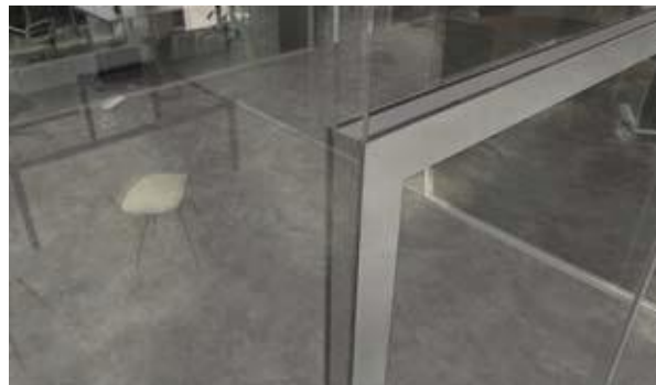
Durų stakta, įtaisyta dvigubo stiklo pertvaroje.
