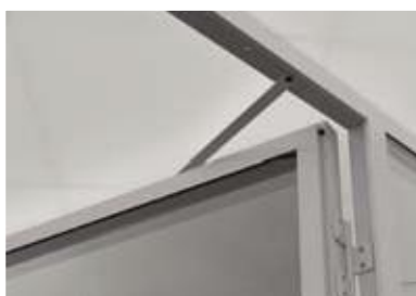
Paslėptas automatinio durų uždarymo mechanizmas. Nuleidžiamas sandariklis durų apačioje.
