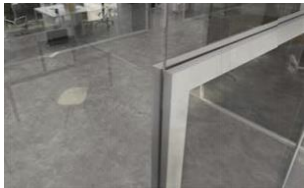
Durų stakta įtaisyta viengubo stiklo pertvaroje profiliuotio centre.
